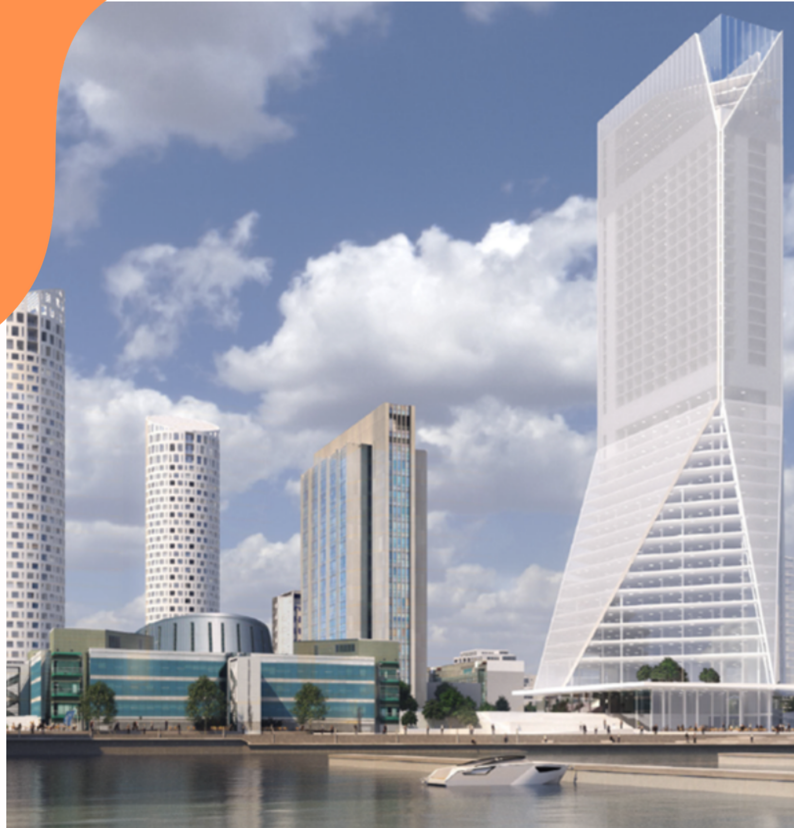
Uusi yhteistoimisto sijaitsee kuvassa keskellä olevassa, matalassa rakennuksessa. Kuva: YIT
